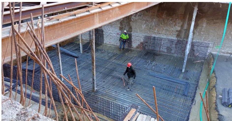
Figura 6.9 Execução da armadura para o maciço de fundação na zona A.
