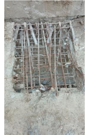
Figura 6.8 À esquerda, grampos incorporados nas bandas de laje para solidarização entre betão com idades diferentes. À direita, negativo deixado na zona onde irá passar o pilar na fase definitiva.
