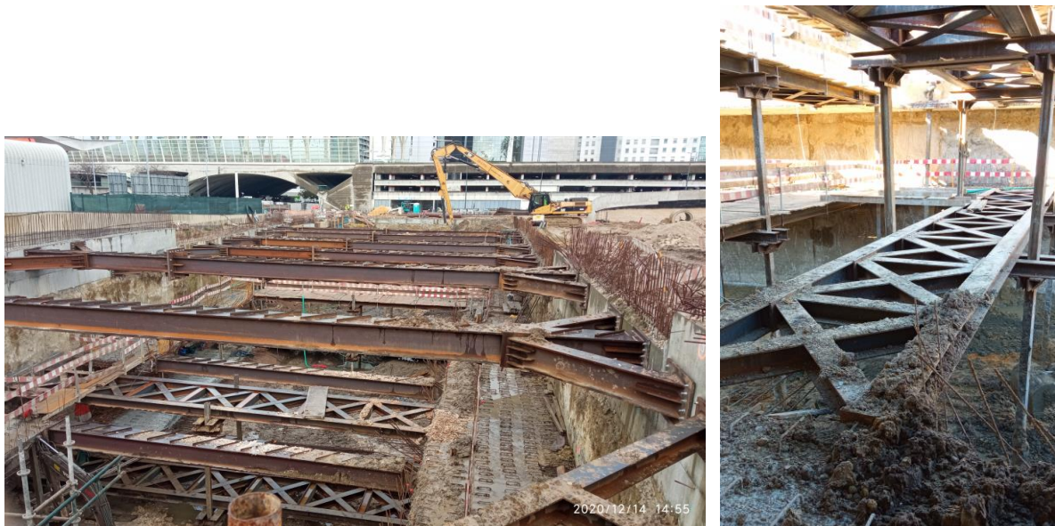
Figura 6.4 Escoramentos metálicos com ligação às paredes moldadas e às bandas de laje com apoios verticais de suporte.
