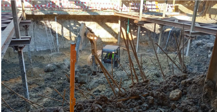
Figura 6.5 Equipamento de escavação a executar a escavação entre o piso -2 e a cota de fundo da escavação, na área entre os escoramentos.
