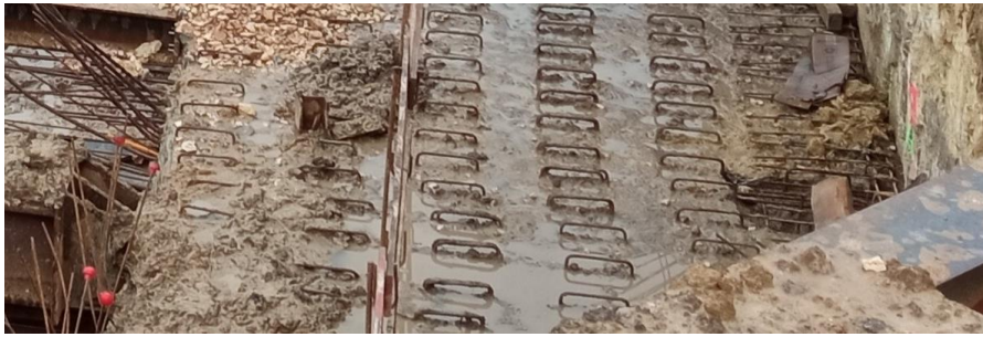
Figura 6.8 À esquerda, grampos incorporados nas bandas de laje para solidarização entre betão com idades diferentes. À direita, negativo deixado na zona onde irá passar o pilar na fase definitiva.
