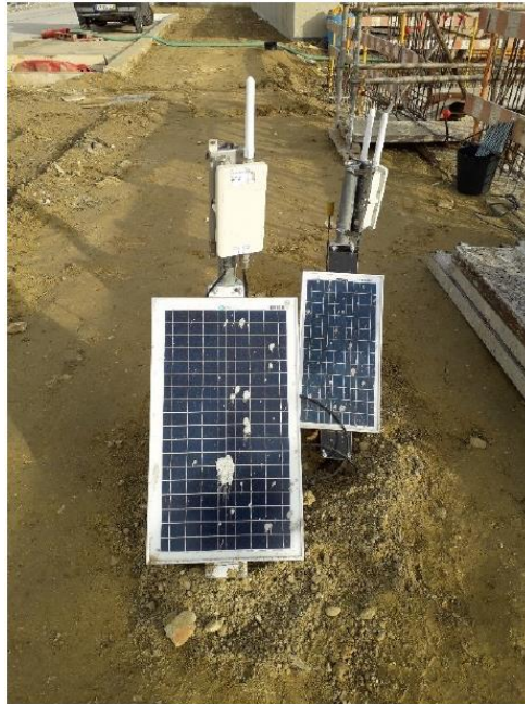
Figura 6.14 Zona Instrumentada 1 localizada no alçado AE do Lote 1.
